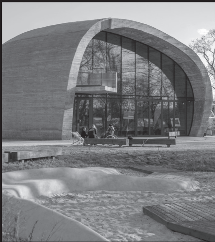
PAWILON KAMIEŃ I POLANA NA GOŁĘDZINOWIE THE KAMIEŃ [STONE] PAVILION AND THE CLEARING IN GOŁĘDZINÓW
