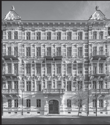
DWIE KAMIENICE PRZY FOKSAL TWO TENEMENT HOUSES IN FOKSAL STREET
