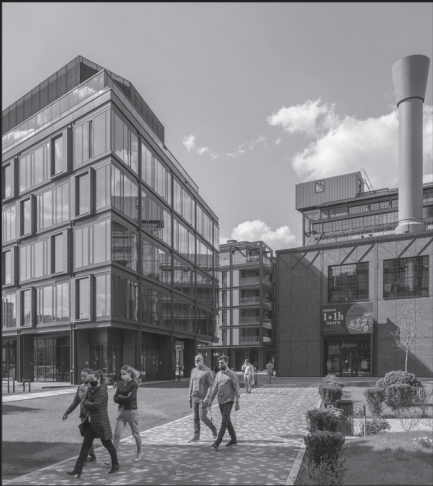
ELEKTROWNIA POWIŚLE POWIŚLE POWER PLANT
